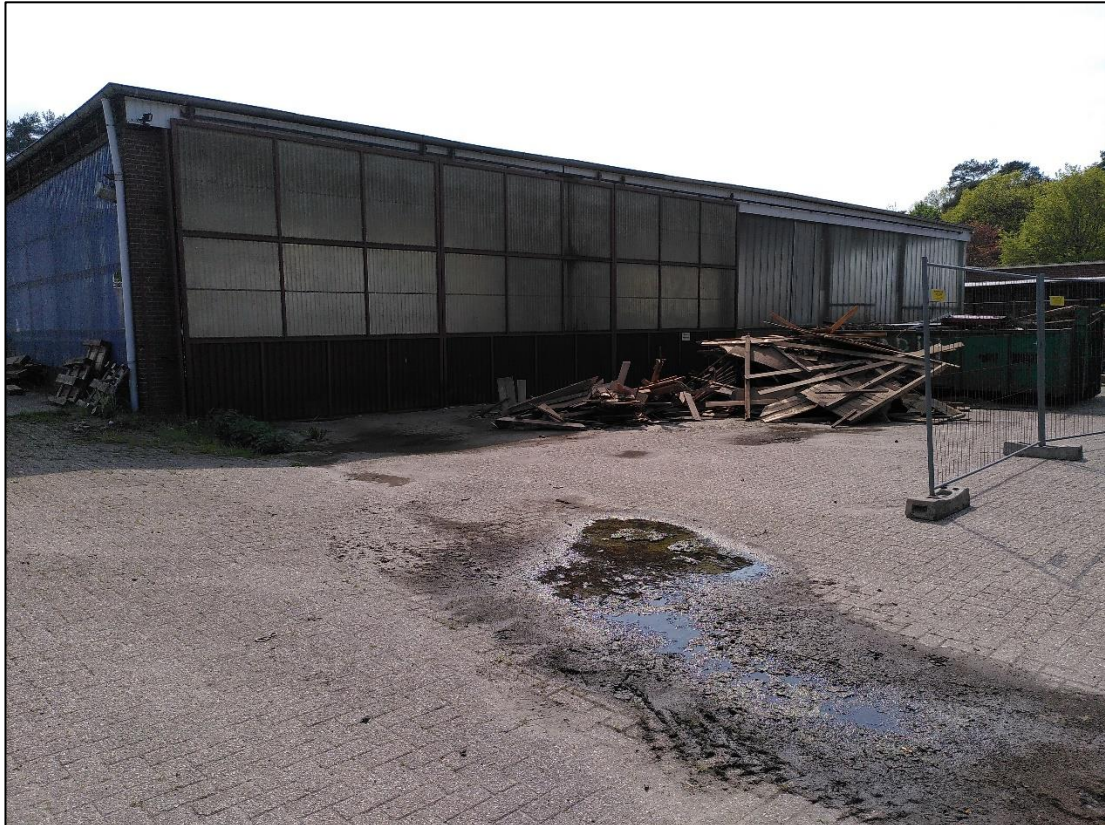
Abbildung 6: Leerstehende, im Rückbau befindliche Gewerbebauten im südlichen Plangebiet. Foto: Stutzmann, Mai 2023.
