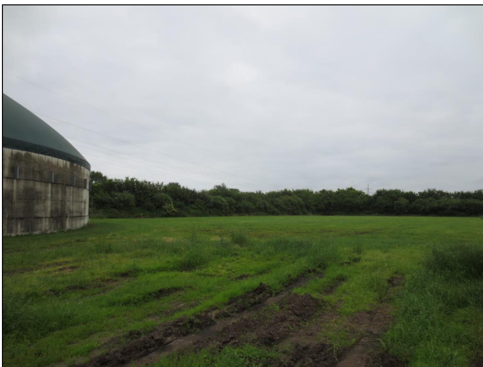
Abbildung 3: Blick auf die derzeitige Havariefläche, Blickrichtung von West nach Ost. Zu sehen ist links im Bild ein Gärrestlager, ebenfalls links die Hochspannungsleitung, im Hintergrund der Havariewall mit Strauch-Baumhecke und im Vordergrund die mit Ackergras eingesäte Ackerfläche. Aufnahmedatum des Fotos: 03.06.2024.
