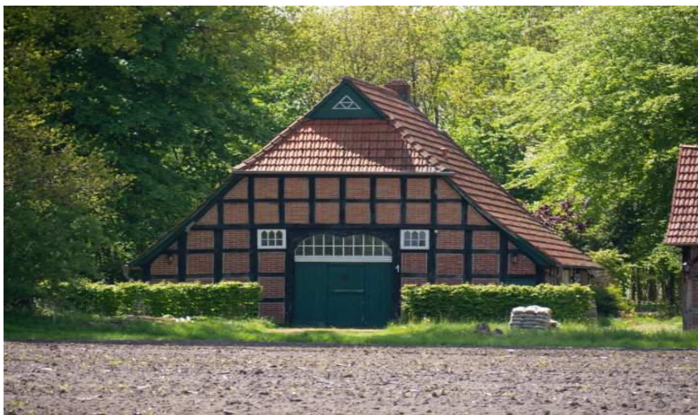
Abbildung 78: Wohn- und Wirtschaftsgebäude von 1813 mit ausgemauerter Fachwerkkonstruktion in Döhlen
