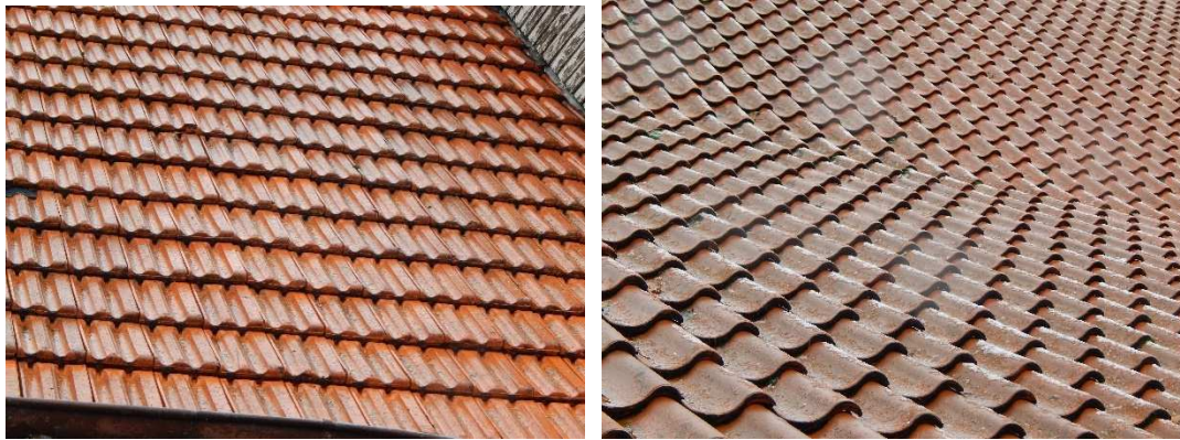
Abbildung 85: Doppelmuldenziegel (links) und Hohl(falz-)ziegel (rechts)
