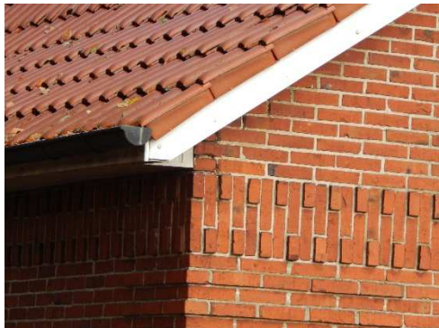
Abbildung 86: Kurze Dachüberstände
