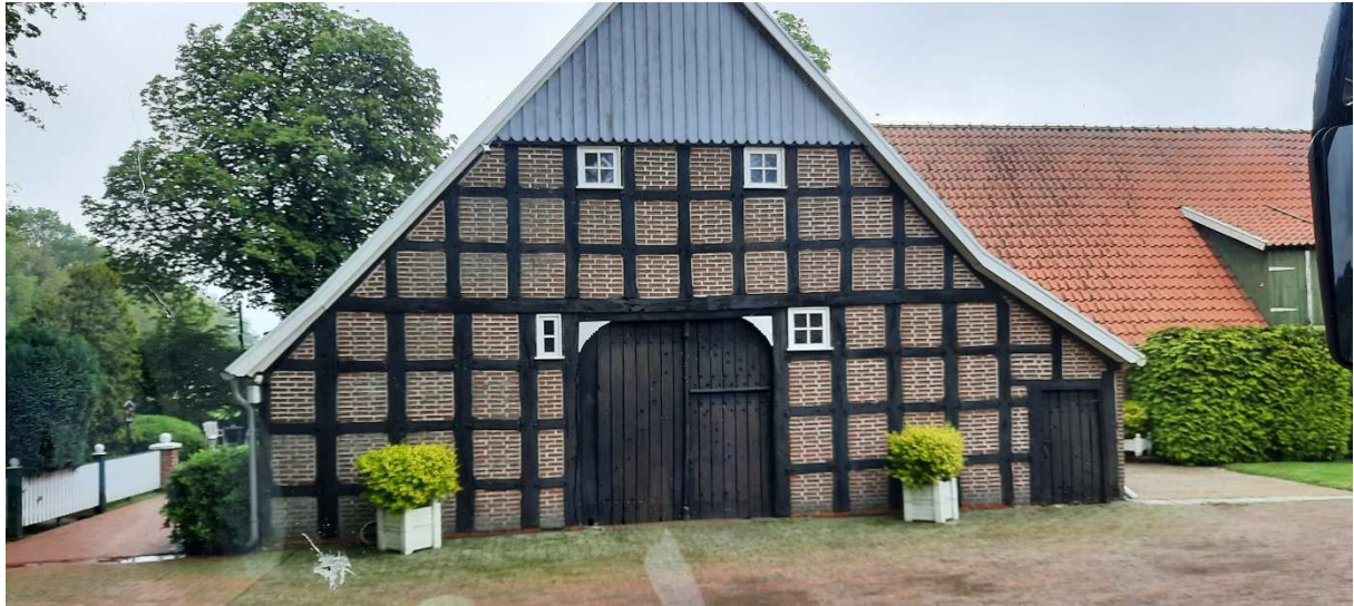
Abbildung 27: Beispiel eines ortstypischen Gebäudes
