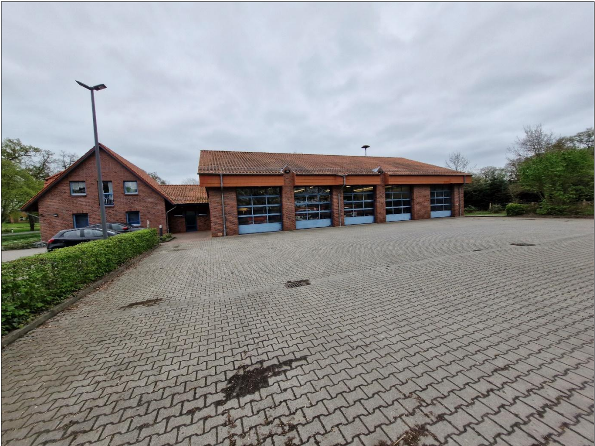
Abbildung 5.5 Foto Feuerwehrhaus Großenkneten
