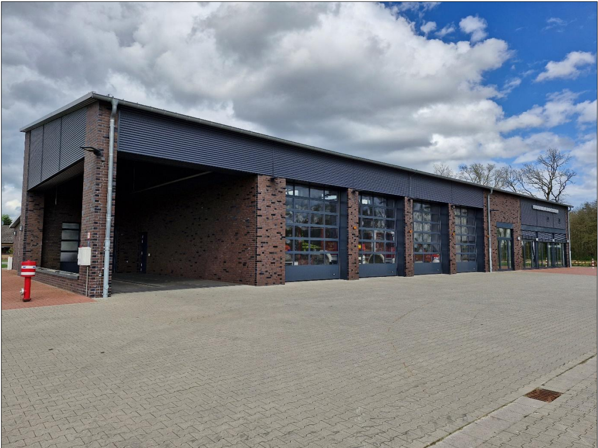
Abbildung 5.6 Foto Feuerwehrhaus Huntlosen
