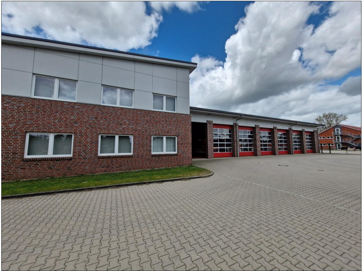
Abbildung 5.4 Foto Feuerwehrhaus OFW Ahlhorn
